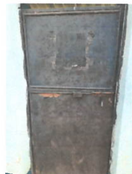
Foto 2: Suministro e instalación de puerta metálica, incluyendo chapa, bisagras.
