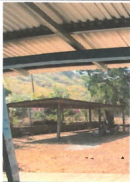
Foto 1: Sustrucción de cubierta de techo con lámina galvanizada, Tipo de lamina: troquelada Calibre: 26, incluye: fijaciones y sellado en traslapes.
