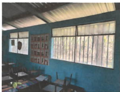
Foto 3: Sustrucción de ventanas; sistema de apertura: Corredizas, Perfiles color blanco estandar, Material del marco: PVC Material de la ventana: Vidrio, sellado perimetral.
